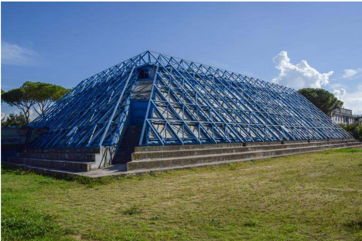
Palazzetto dello Sport, Bastia Umbra, progetto G. Leoncilli Massi, 1972, Foto Luca Tesi da MiBAC, Architetture del secondo Novecento, 2018 2
